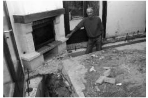
La pose de micro-pieux par l'intérieur de la maison a été rendue nécessaire. L'aboutissement de deux ans de démarches PHOTO STEPHANE PAPEAU
