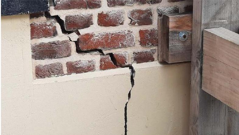
Image d'illustration. Maison fissurée après la rétractation d'un sol argileux dans le nord de la France. © Radio France - Odile Senellart
